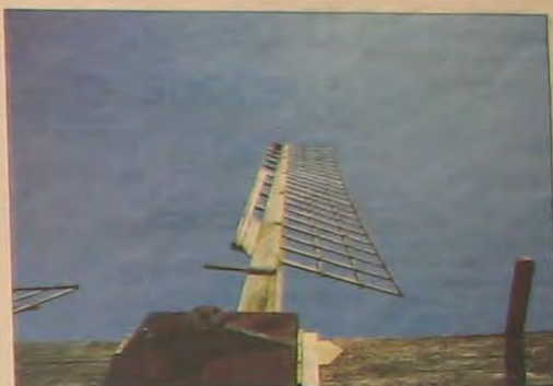
Oprindeligt var hækværket af douglasgran. Men det nye er af sibirisk lærk, og det har flere årsager: Det har næsten samme farve, som det oprindelige, det er meget holdbart og så er det en træsort, som også vokser i Danmark.
