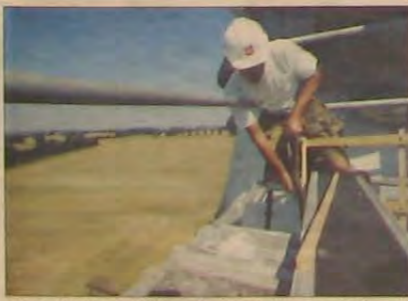
Yngve Jönsson passer træet til. Alle stykker er lavet på værkstedet og mærket med romertal, så tømrerne kan se, hvilket stykke, der passer hvor på møllen.
