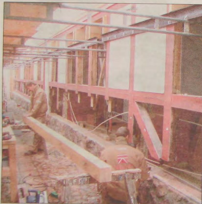
Bindingsværket på vagtbygning på Gråsten Slot er ved at blive udskiftet.
