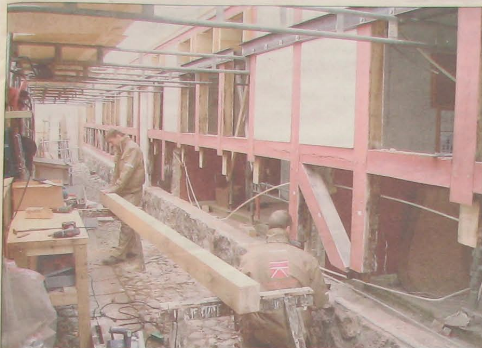
Medarbejderne fra tømrer- og snedkerfirmaet Karl D. Petersen i Avnbøl i gang med renoveringen af vagtbygningen på Gråsten Slot
