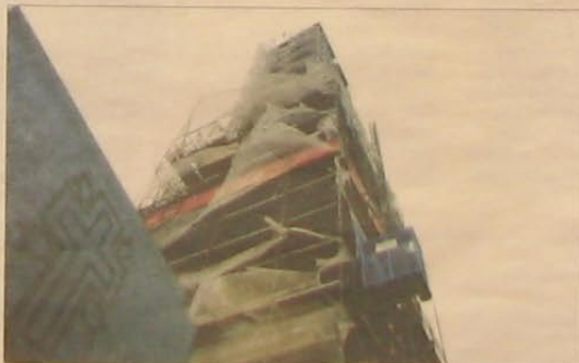
Sottrup Kirkes tårn er pakket ind i stilladser og net. Den blå elevator på siden kører de første 30 meter op. De sidste 20 meter tages ad stiger.
