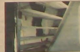
Mølleren har taget mange skridt på trappetrinene, og det kan ses. Derfor skal trinene snart skiftes.
