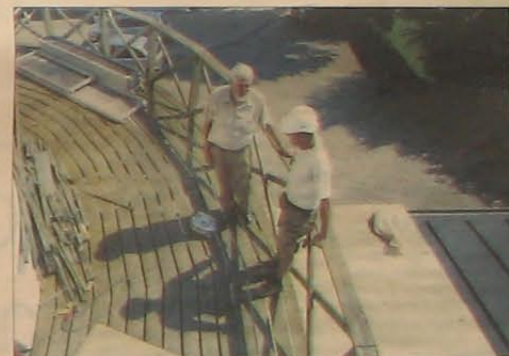
Tømrermester Svend Anker Petersen og tømrer Yngve Jönsson får en snak om det forestående arbejde. Til venstre ligger det gamle hækværk, som skal kasseres.
